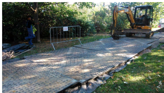
Obr. 45 - Ochrana před zhutněním KZ.
