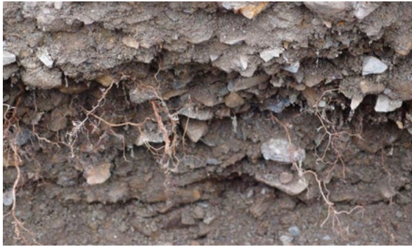
Obr. 8 – Prokořeněná vrstva pod chodníkem.
