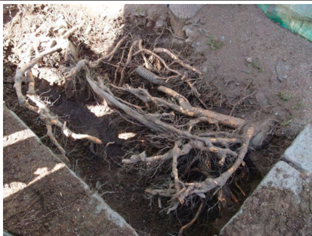
Obr. 46 - Využití nedestruktivního způsobu výkopu v oblasti SVKT a KKZ.
