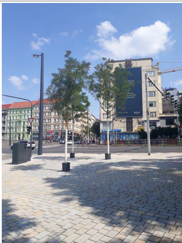
Obr. 41 – Krytová vrstva se širokou spárkou
