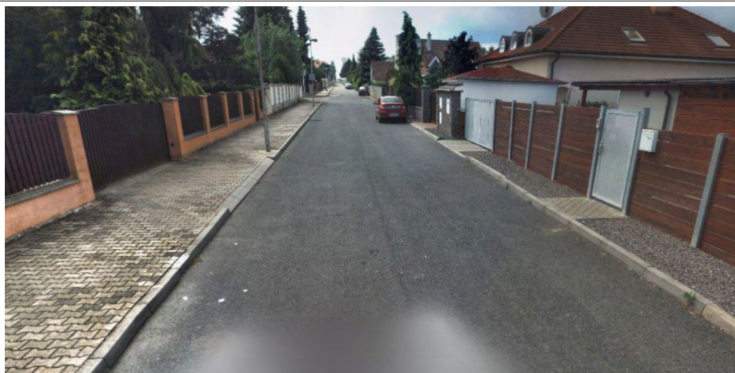
Obr. 40 - Příklad nevhodně provedené obytné zóny s předimenzovanými dopravními plochami, bez možnosti výsadby.
