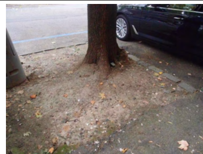
Obr.14 – Zvýšení terénu stromové mísy blokuje nátok srážkové vody.
