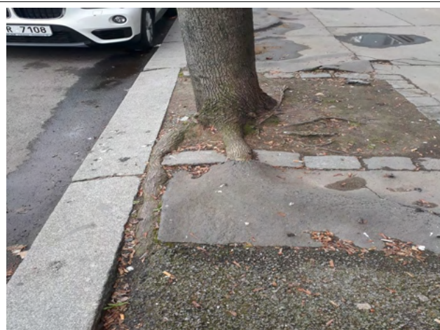
Obr. 6 – Úspěšně rostoucí stromy se snaží kompenzovat limity výsadbové jámy prorůstáním pod okolní povrchy.
