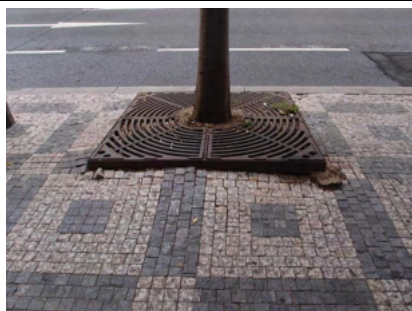
Obr. 12 - Zvýšení hrany blokuje nátok vody.
