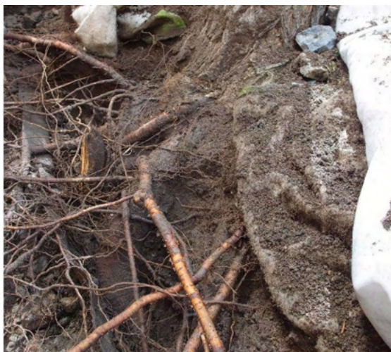
Obr. 10 – Kořenová bariéra cca 0,25 m od osy kmene.
