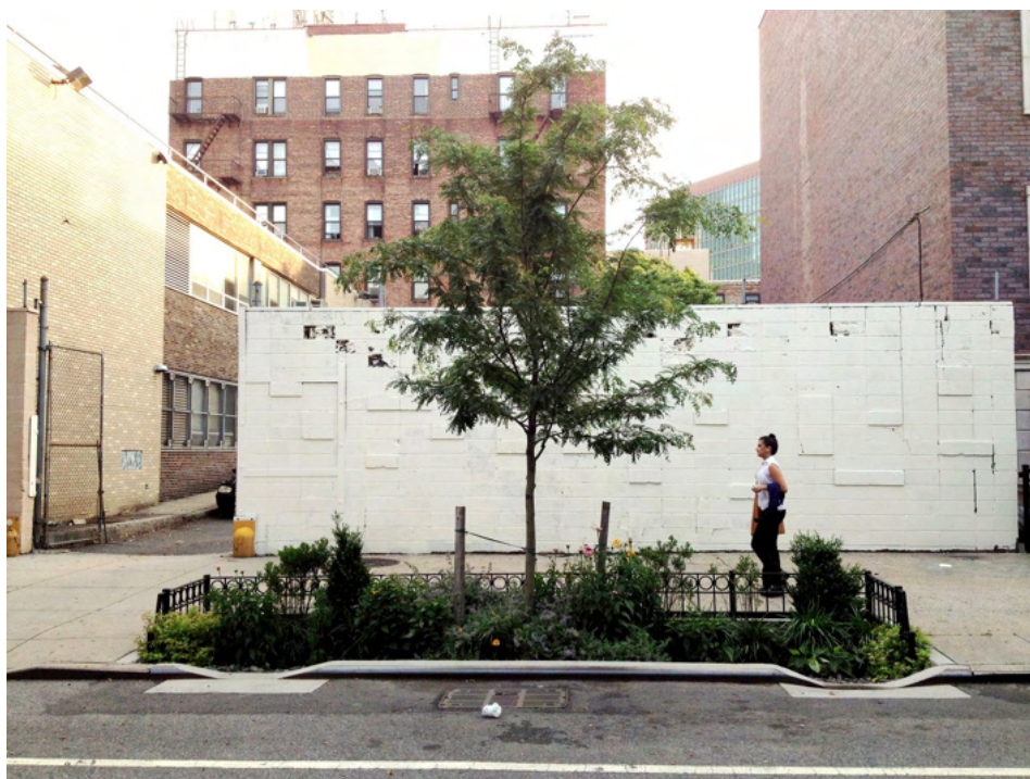
Obr. 38 – Referenční princip spojení výsadby stromu s uličním průlehem jako příklad optimalizace systémů MZI.
