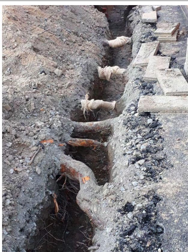
Obr. 48 - Ruční výkop se zachováním kořenů ve sdíleném kořenovém prostoru.
